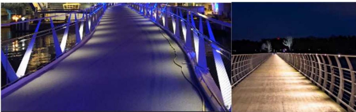
Figur 138 (foto Oskar Bruneby) räckesbelysning HLS LED puckar. Till vänster LED puck i handledare i en ganska ljus miljö och de bländar inte rullstol och barn. Till höger i en mör miljö där har man en lägre effekt och sätter LED puck i toppföljaren 1400mm upp.
