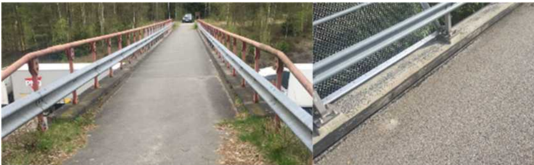
Figur 119 (Foto Oskar Bruneby) Plattamar med beläggningsarbete som är 30 år till vänster och 20 år till höger och verkar kunna håll lång till dessutom verkar det bra vid övergångarna mellan bro bank.
