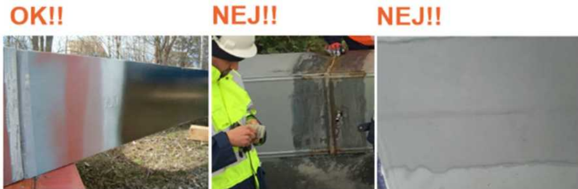
Figur 77 (Foto Oskar Bruneby) Med följande bilder kan alla se hur en målningsskarv skall se ut i Sverige. 5 lager färg i olika kulör och detta kan enkelt förklara tidigt och synas redan på verkstaden.
