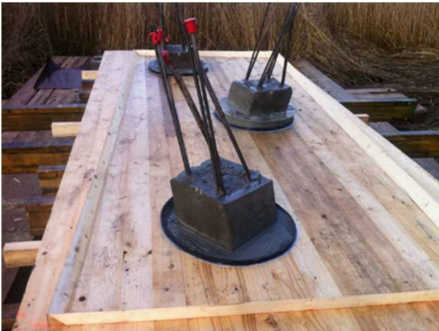
Figur 59 (Foto Oskar Bruneby) visar bottenform och betongpelare göt stöd bro Sölvesborgsviken med aktiva byggherreval och gjort rymdramsberäkningar på pälgruppen. Det är många stöd på denna bro så etableringskostnaden blir minimal för pälkranen.
