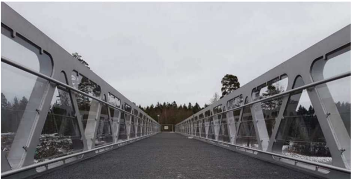
Figur 104 (foto SRMAB) SRMAB konceptbok med Hammer glass 4000 kr /m 2 bro Södertälje
