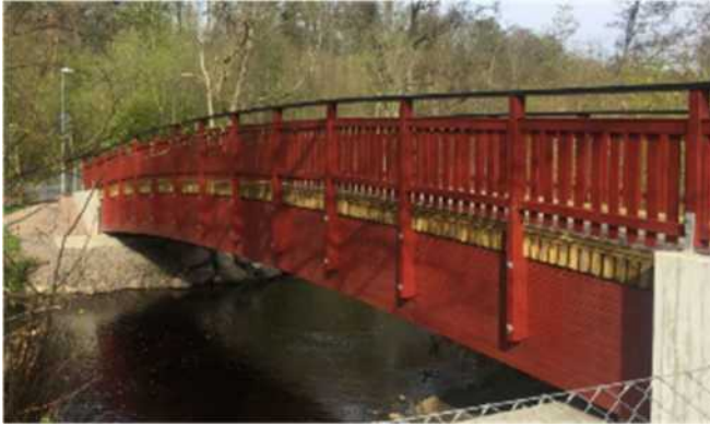
Figur 113 (foto Oskar Bruneby) Visar träräcke på träbro Pomona Ängelholm och normsystem tillåter inte detta då man kräver livslängd 80 år på ett räcke men går att ändra med ett byggherrebeslut.
