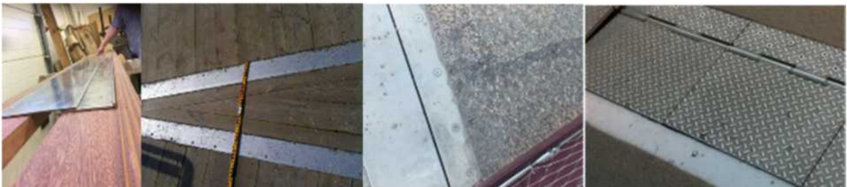
Figur 133(foto Oskar Bruneby) a, b, c och d, Från vänster a Nedföst i ädelträ tullportsbron Ängelholm. b Ned frästa enkelplåtar i vinkeländring Bro Sölvesborg. c hel vik plåt med gångjärn under Sofias broa Helsingborg, d Delade vikplåtar på rörlig gcbro Gdansk.
