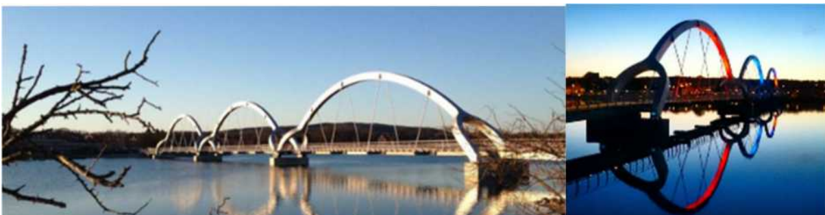
Figur 73 (foto Oskar Bruneby) Bro över Sølvesborgsviken som har bågar och räcke i LDX 2101 som kommer att spara många kronor i underhåll jämfört med målat. Det är väldigt dyrt att måla på toppen av en båge i havet.
