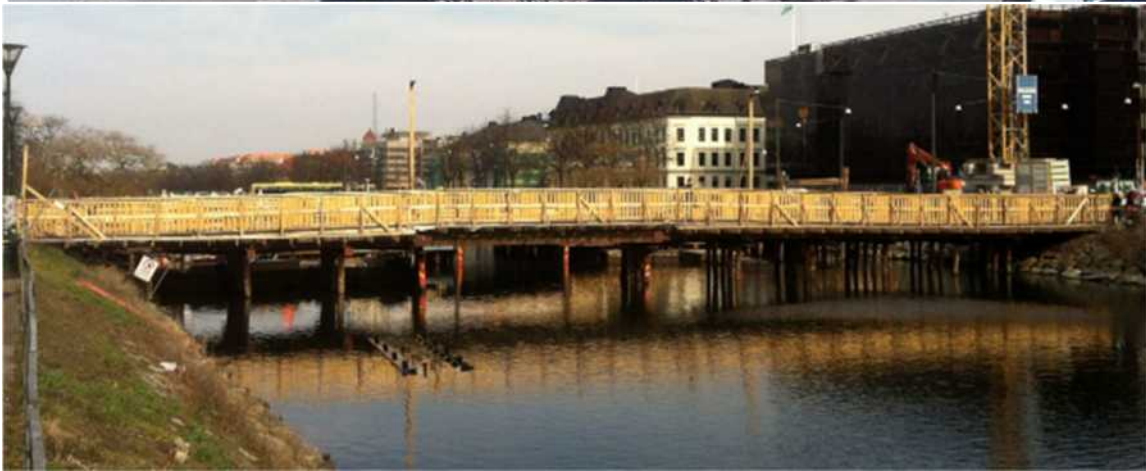
Figur 49 A (foto Oskar Bruneby) Provisorisk bro vid varvsbron Helsingborg från HAKI. B (foto Oskar Bruneby) Provisorisk bro med pålbrygga vi bygge av Kaptensbron Malmö.
