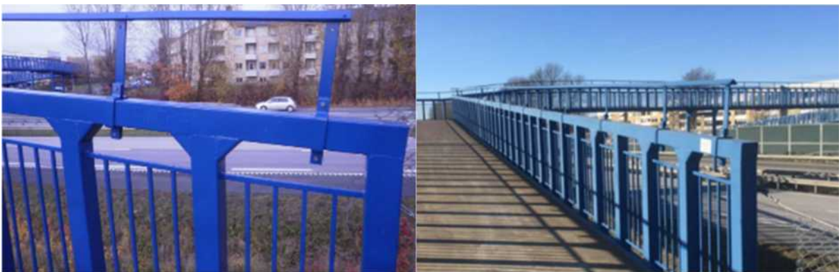
Figur 83(foto Oskar Bruneby) Visar blå bron Kristianstad nymålade 2014 till vänster och till höger kulör 2024. Känslan är att blå och röd färg åldras sämst. Gul och grön klarar sig lite bättre, Bäst är kulör vit, grå och svart.
