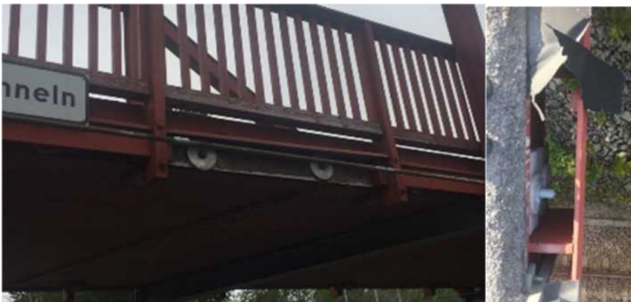
Figur 87(foto Oskar Bruneby) Visar skador på skydd i träbroar som har konsekvenser för livslängden om de inte sköts om.
