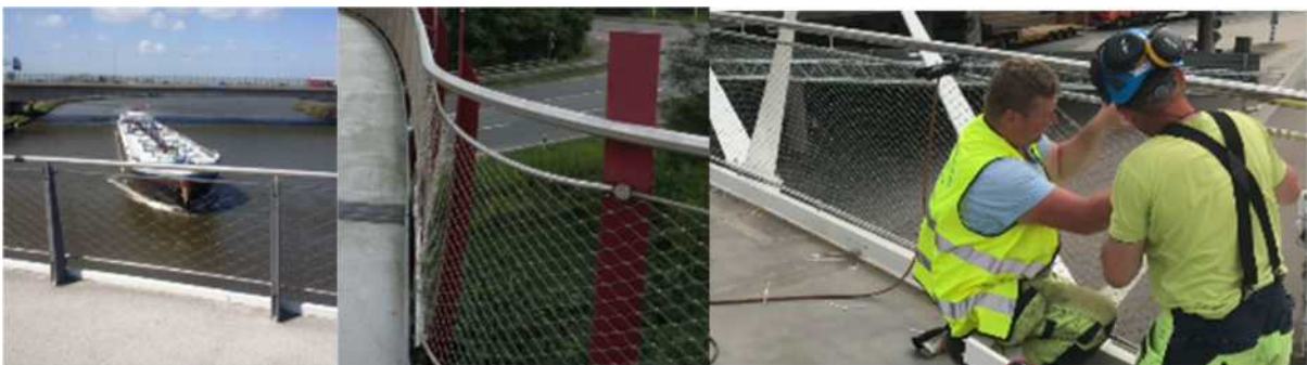
Figur 106 (foto Oskar Bruneby) Nät typ Carl Stahl mech finns i lite olika material och storlek på maskorna. Det sys fast på plats och det är linjen på det man ansluter till och hantverkskänslan som styr resultatet 2000kr/m 2
