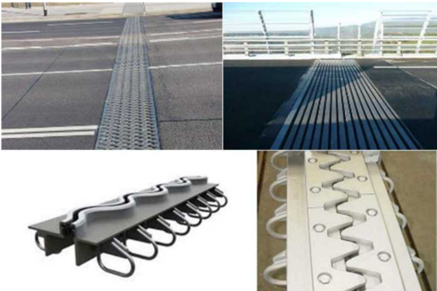
Figur 135 a,b,c och d foto (Mageba) a Fectt fog, b swivvel fog, c sinus fog, d finger fog
