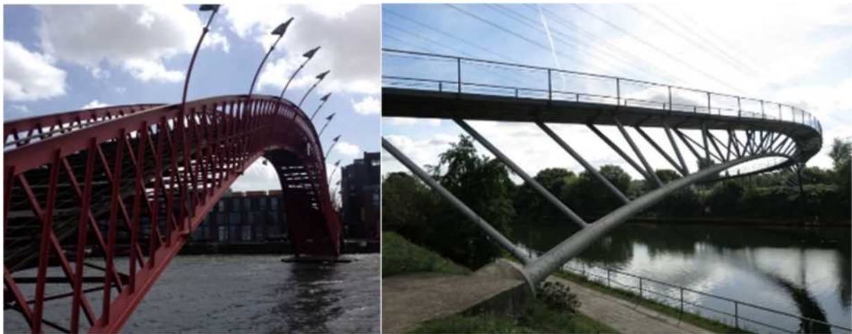
Figur 37A (foto Oskar Bruneby) Visar Fackverksbro i bäge Anaconda bridge Amsterdam. B (foto Oskar Bruneby) Visar Ribshorst brücke Oberhausen Tyskland Som är en inspänd bro som hanterar sina rörelser svängd brogeometri.
