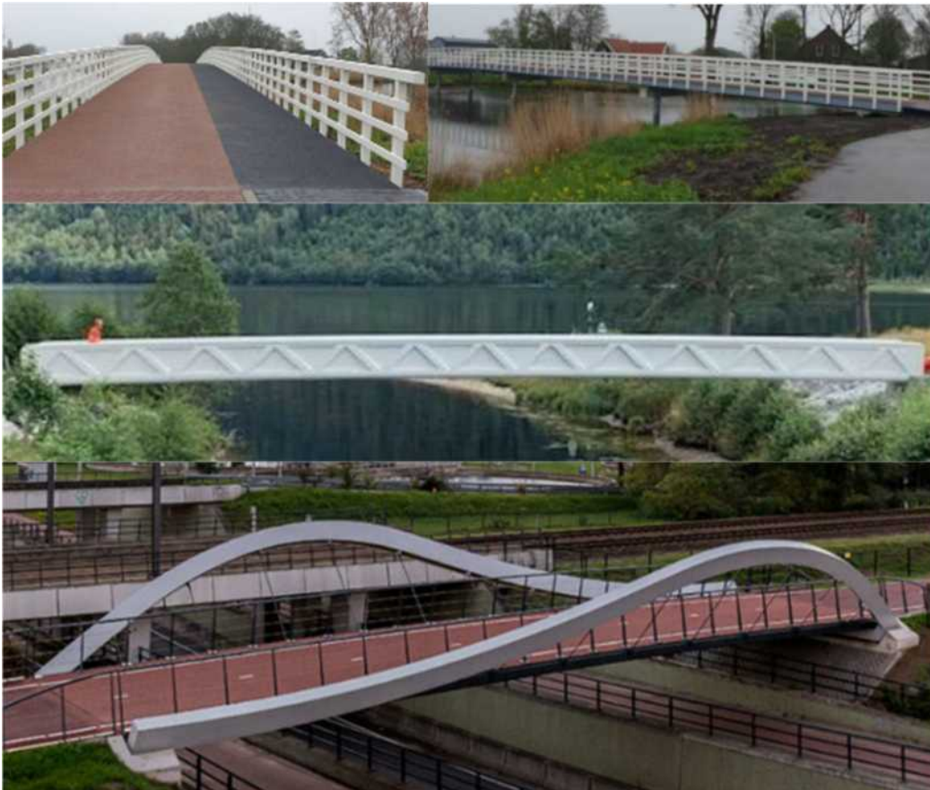
Figur 92(foto Fibercore) Visar ett axplock ur Fibercores produktion. Lite klumpigare ön stål svårt att skarva på plats och fabrik i Holland innebär viss utmaning i logistik. Det salt resistent materialets möjligheter. Kostnaden är ungefär samma som en rostfri bro.
