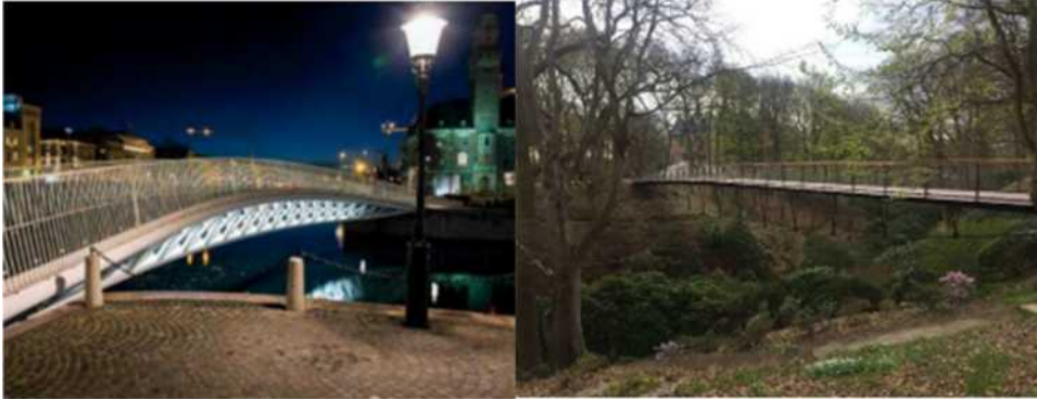
Figur 26 Exempel broar med dynamikproblem till vänster (Foto Lars Bendroth Malmöstad) Bagers bro Inspänd bro i kurva ca 2m bred och cirka 30m lång.) Tillhöger (foto Oskar Bruneby) Sofias bro sinusformad 60m lång.
