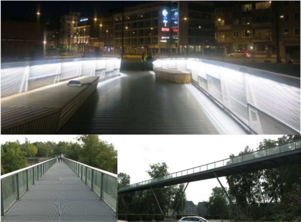
Figur 137 (foto Oskar Bruneby) Broar som är mer lampor än broar. Överst bro entré Malmö live. Under bro i Duisburg Tyskland som har belysning under slasskivorna som lysas upp, tänds och släcks medan man går var dock svårt att fotografera.
