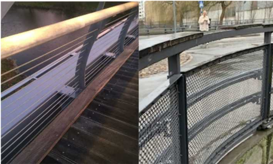
Figur 111 (foto Oskar Bruneby) Visar handledare i trä som ger en mjukare känsla men burkar inte ha så lång livslängd då trä och stål rör sig olika vilket gör att skruvar dra ut med tiden och vilket krokmar
