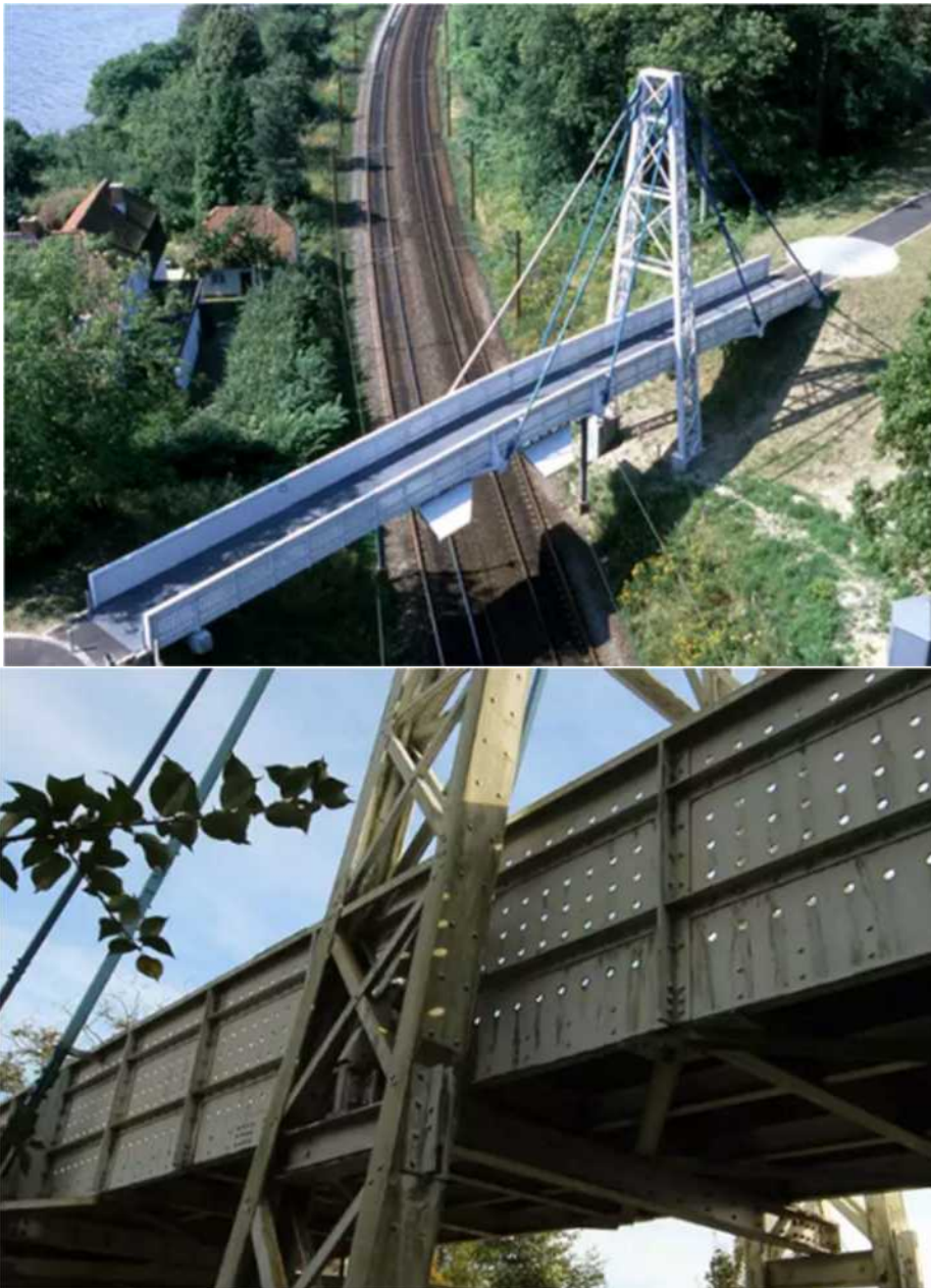
Figur 94 bilder från Fiberline där man får en känsla av legosystemet med bultar. Som en gammal järnvägsbro. Vid studiebesök konstateras att bron verkar fullständigt intakt efter 25 år.
