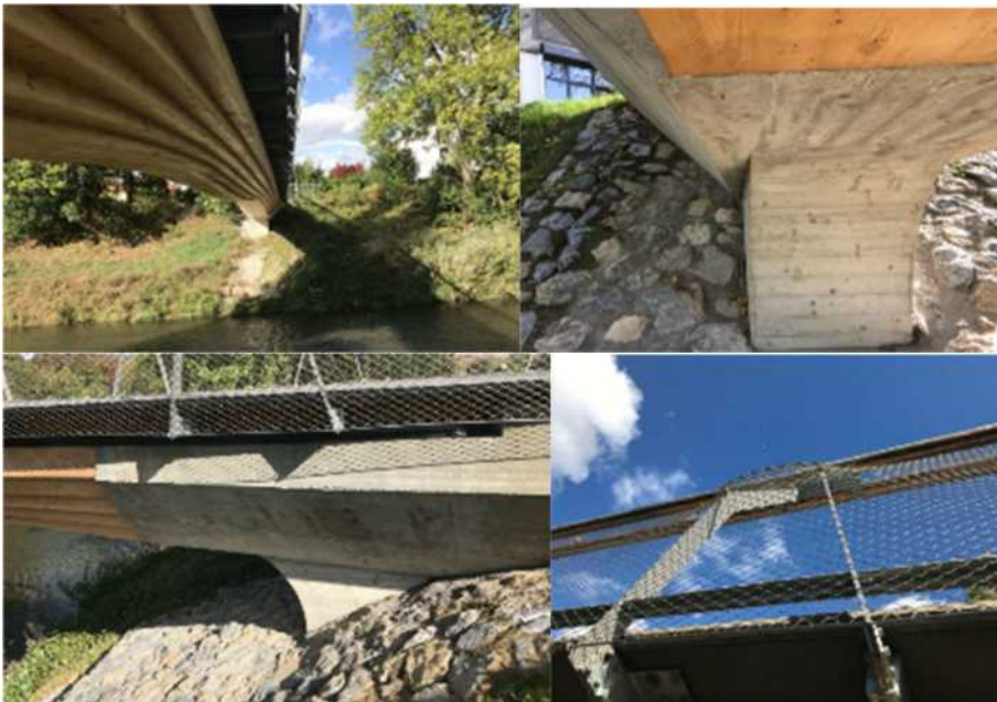
Figur 90(foto Oskar Bruneby) Studiebesök vid Stuttgarter holzbrücke spännvidd 38m bygga 2017 där man förenat betong platsgjutet, betong Prefab, och smidesräcke. Limträet är bara en del i brobyggandet. I Sverige har vi tidigare bar tänkt TRÄBRO.
