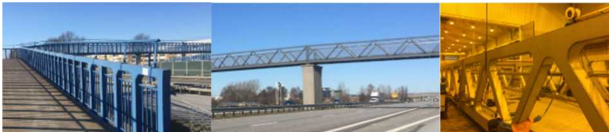
Figur 74 Första generationen fackverks gång och cykelbro 60-70tal b Andra generationens fackverks gång och cykelbro c kanske 3dje generationens fackverks gång och cykelbro
