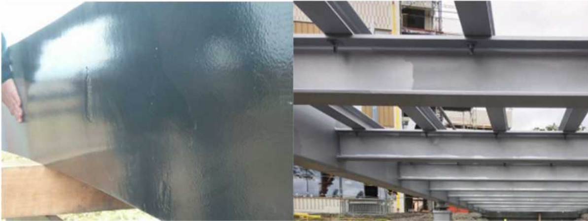
Figur 80 (foto Oskar Bruneby) Fotot till vänster visar att en blank kulör avslöjar stålets ytstruktur, det inte är som en bilplåt. Fotot till höger visar en metallic lack som är bättrad med exakt samma kulör men metallic kornen lägger sig olika.
