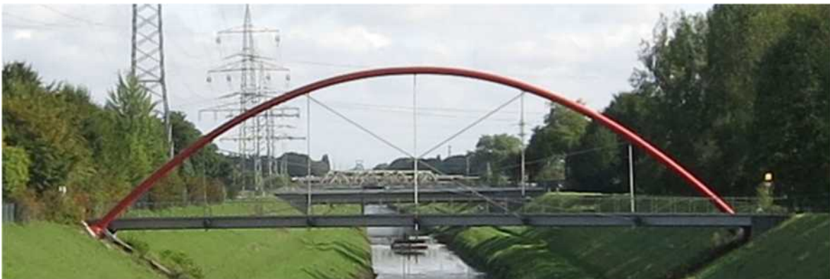
Figur 41. (Foto Oskar Bruneby) Visar väldigt material effektiv och minimalistiska båge på 45 m i Kusntpark ost Tyskland. Denna brotyp skulle kunna systematiseras i kanske 40m, 50m och 60m längd. Detta skulle vara en tillgång för vatten och motorvägar som annars brukar kräva extra stöd som skall göras i vatten eller trafik som är väldigt dyrt.
