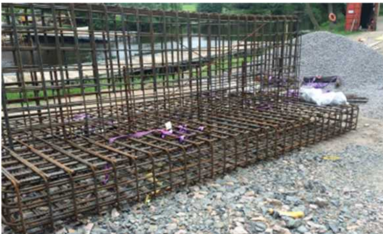
Figur 51 Visar att bottenplatta och landfästes armering ibland inte är större än man kan prefabricera merparten av jobbet utom själva gjutningen och bedriva arbetet med minimal etablering.
