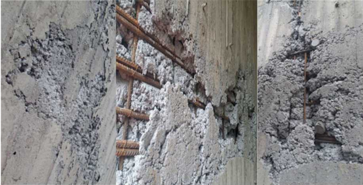
Figur 64 Visar gjutskador gjorda 2023 som dessvärre förekommer oftare. Trenden är att många broar är bra men när de väl blir fel och mycket gjutskador. Detta tyder på mycket att det finns mycket skillnader på rutin och kompetens bland hantverkare som skall kunna förbättras
