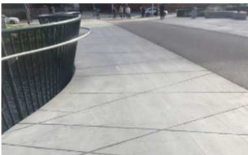
Figur 120 (Foto Oskar Bruneby) Kaptensbron gjordes enligt arkitektens önskingar helt slät och mönster för att dölja sågsnitt för rörelser. Efter att tag kunde man konstatera att den tänkta ytan inte var lämplig och stål kulblästrade yta och friktionen bra.
