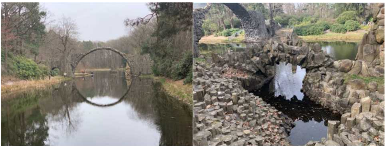
Figur 39. (Foton Oskar Bruneby) A Visar the Devilsbridge i östra Tyskland. B Visar the hur man kan bygga en liten stenvälvbro och att stenarna kan vara lite basaltskrot.
