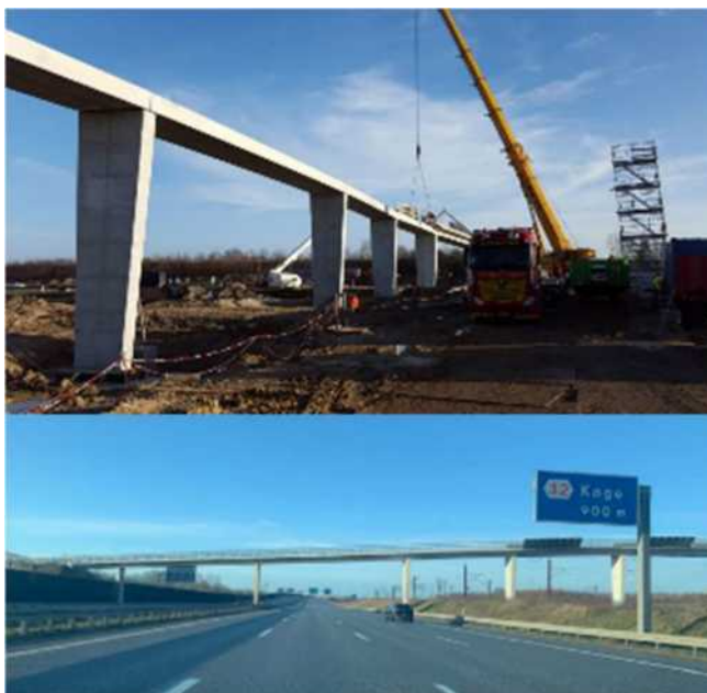
Figur 48 A (foto Consolius) Køge Danmark montage 2016 av bro 24m spännvidd B (foto Oskar Bruneby) samma bro men 2022.
