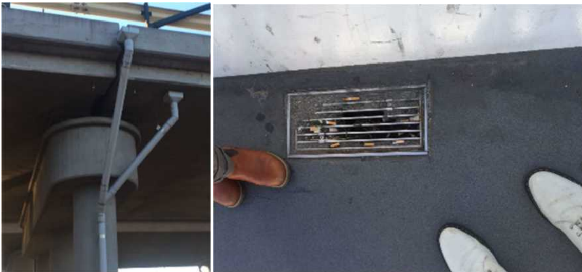
Figur 142 (foto Oskar Bruneby) Visar broar som inte haft tillfredställande plan för avvattning. Man kan säga att askkopparna kom lite lågt!
