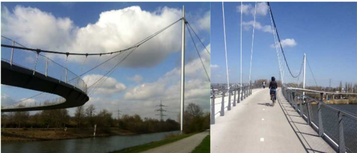
Figur 44. (Foto Oskar Bruneby) A. Zoom bridge utanför zoo i Gelsenkirchen Tyskland som har ett imponerande 144m långt svävande spann i en båge. B Visar Nescio bridgen Holland som är Europas näst längsta bro ca 730m.
