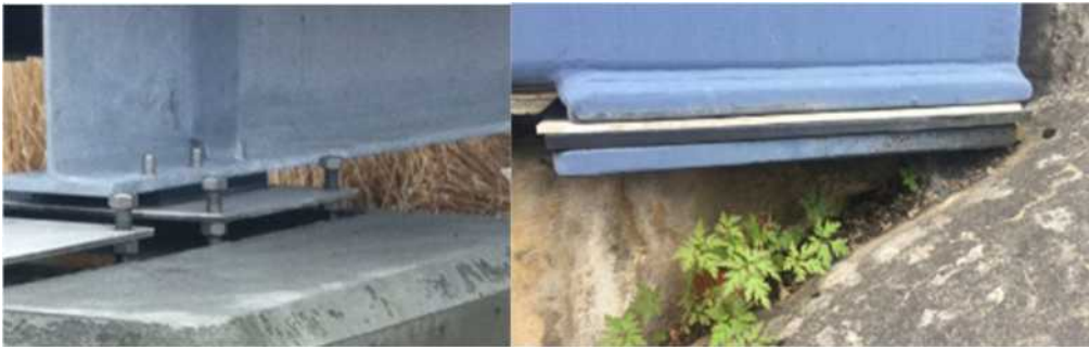
Figur 126 (Foto Oskar Bruneby) Visar till vänster lager med stålplåt med tappar gummidyna och till höger visas lager med gummidyna och teflon
