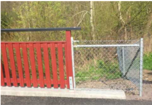
Figur 114 (foto Oskar Bruneby) Visar att det brukar missas med övergångar i räcke och kanske inte helt optimalt, träbro Pomona Ängelholm.
