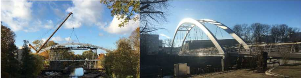
Figur 40. (Foto Oskar Bruneby) Visar Tullportsbron en 80 m bågbro i Ängelholm vid montage och färdig bro.
