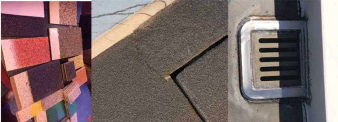
Figur 121 (Foto Oskar Bruneby) Det är nästan helt gränslöst med kulör och sten möjligheter. Friktionen bör vara god men inte bättre än man klara att trilla utan att skrapa sig helt. Det är sedan bar att utforma hörn rundade för enklare
