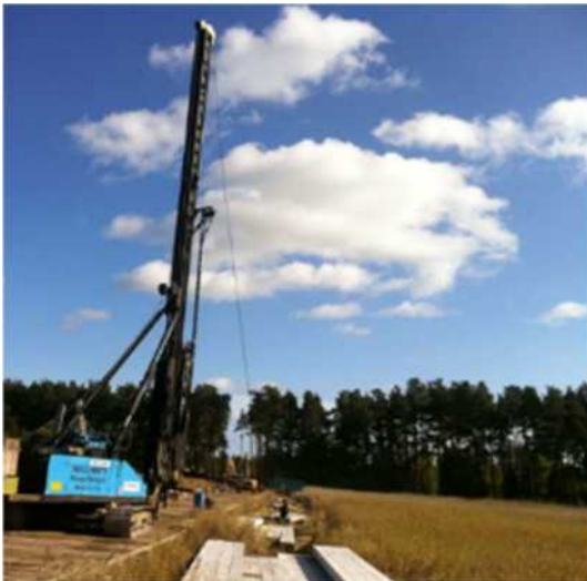
Figur 53 (foto Oskar Bruneby) Pålkran typ Juntan Pm23 vid bro Sölvesborgsviken.
