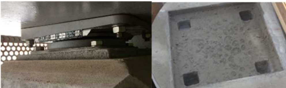
Figur 127 (Foto Oskar Bruneby) Visar till vänster CE Märkt Tobe lager som tar upp lutning i övre plåten. Till höger visas ursparning för lager.
