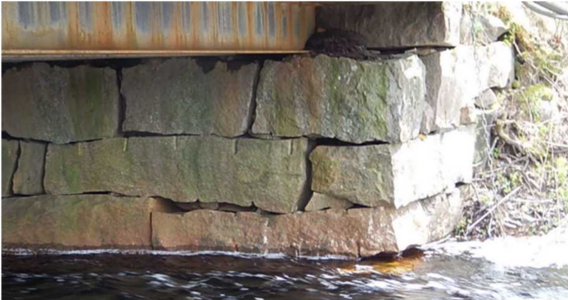
Figur 56 (foto Oskar Bruneby) Bild visar sten landfäste på gammal bro som har börjat röra sig lite.
