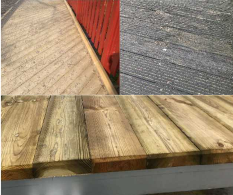
Figur 118 (Foto Oskar Bruneby) lite olika träbeläggningar. Det är alltid bra att lägga virket med sur gubbe fiberriktning som syns på nedersta bilden. Skall man lägga brädorna tvärs körriktningen kan man välja bredden på planken men skall man lägga de längs så skall man välja typ max 150mm och montera de tajt blöta för att få bästa möjliga cykelkomfort.
