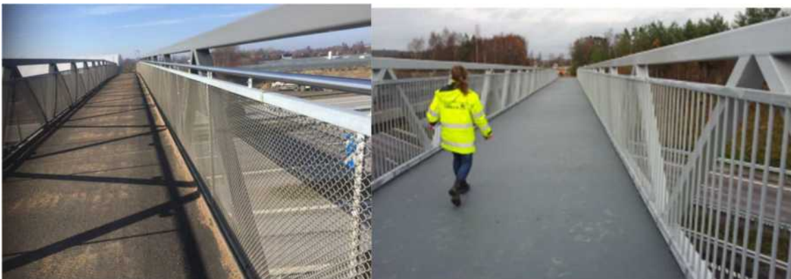
Figur 105 (foto Oskar Bruneby) A nätramar Banverket maska bro Landskrona, B gallergrindar bro Varberg. Båda broar över E6 och 1400mm höga som ger lite fängelsekänsla 2000kr/m 2
