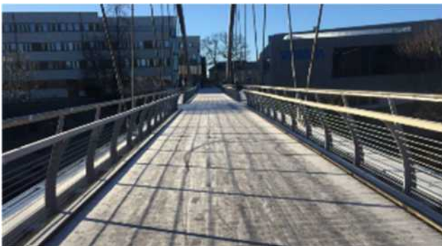
Figur 117 (Foto Oskar Bruneby) Tullportsbron med 5% lutning en vinterförmiddag. Trä kan vara ett ok som materialval till beläggning men aldrig i en stad. Det är alltid mer halt än andra material även om man kan räffla det
