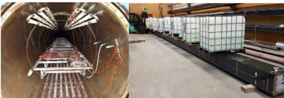
Figur 99 (Foto Oskar Bruneby). Bakning av balk i autoklav och nedböjnings test på färdig balk
